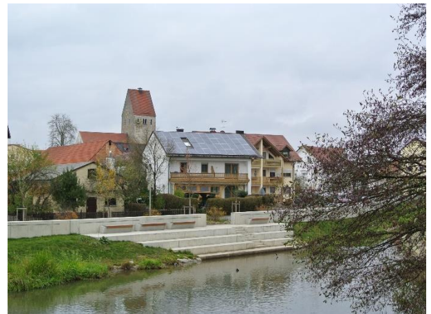
Bild 4: Hochwasserschutz: „Wenn schon, dann gleich richtig!“ Man fragt sich, warum die Träger öffentlicher Belange (hier: Wasserwirtschaftsamt) die Abens so massiv zubetonieren mussten.
