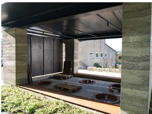
Bild 1: Der georgische Weinkeller (Marani) an der LWG ist fertig – die ersten Trauben sind jetzt in den Tongefäßen (Qvevris) im Boden (Jeannine Steinkuhl, © LWG).
